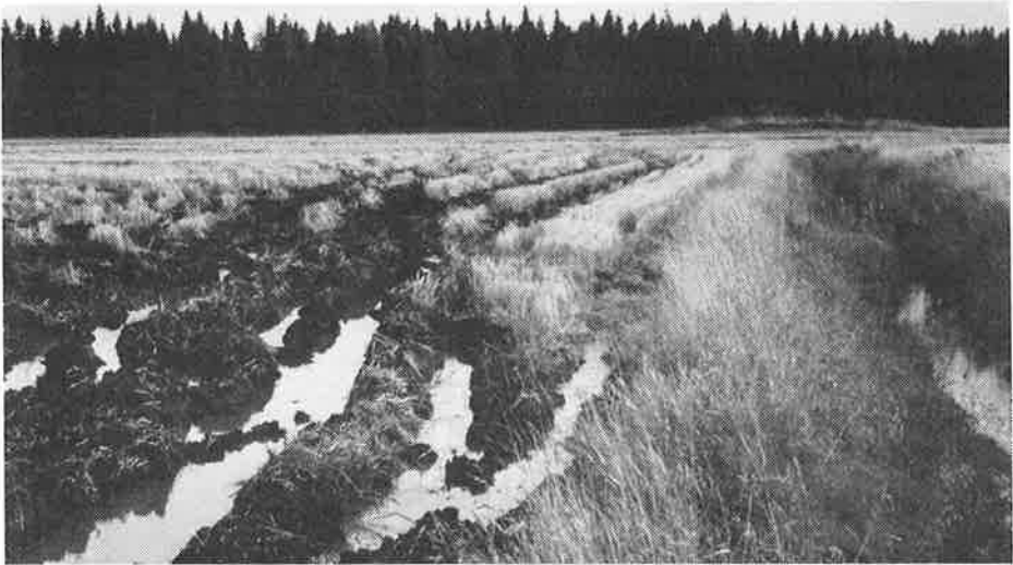
Kuva 1. Tilanne salaojitetulla pellolla sadonkorjuun jälkeen ennen toimintahäiriön korjausta. Vesi seisoo pellolla jopa aivan valtaojan vieressäkin.
